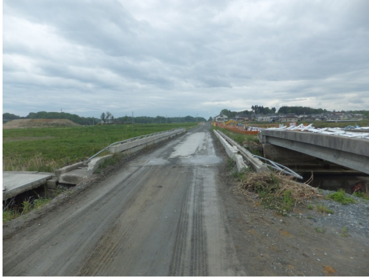
これは常磐線の線路敷地跡です 右の道路のガードレールは津波でなぎ倒されたままです
